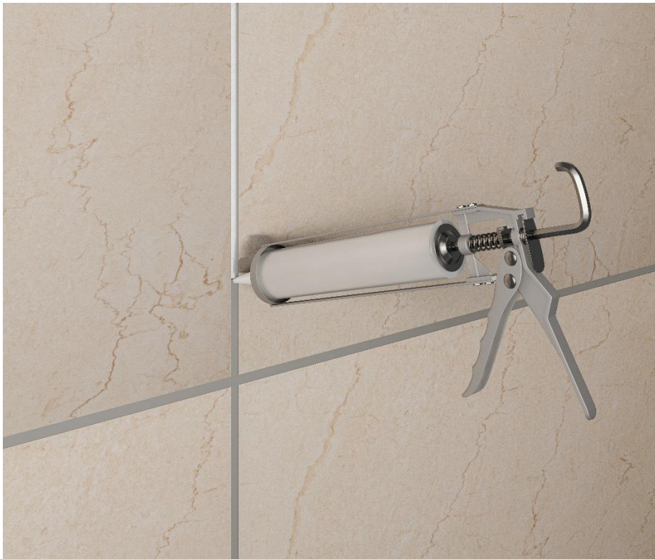
Рис. 8. Герметизация шва
