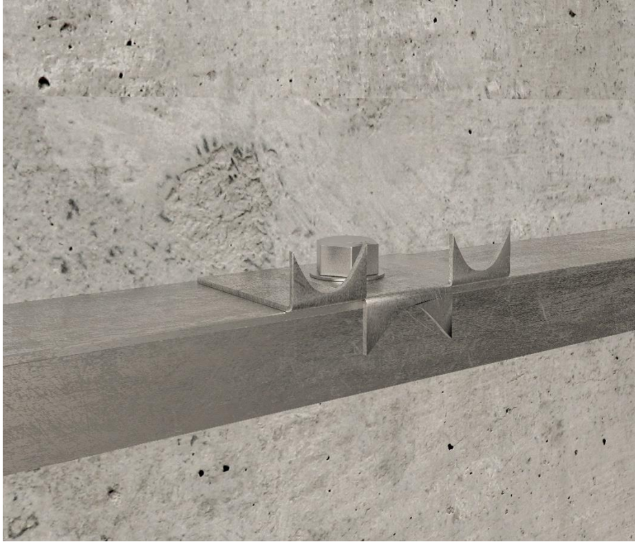
Рис 4 Монтаж направляющего профиля и кляммера
