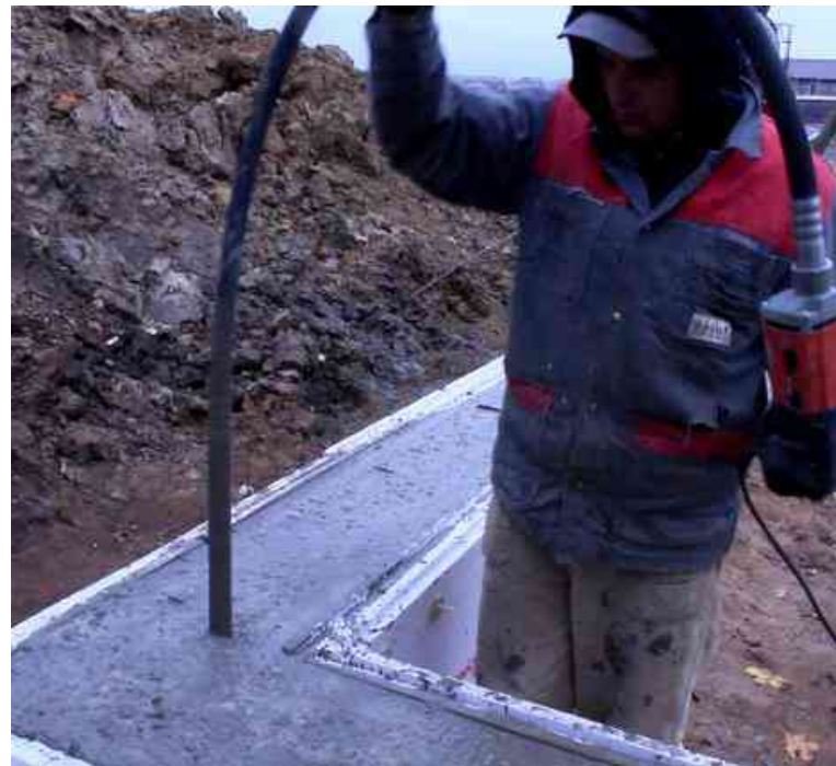
Вибрация бетона с помощью глубинного вибратора.
