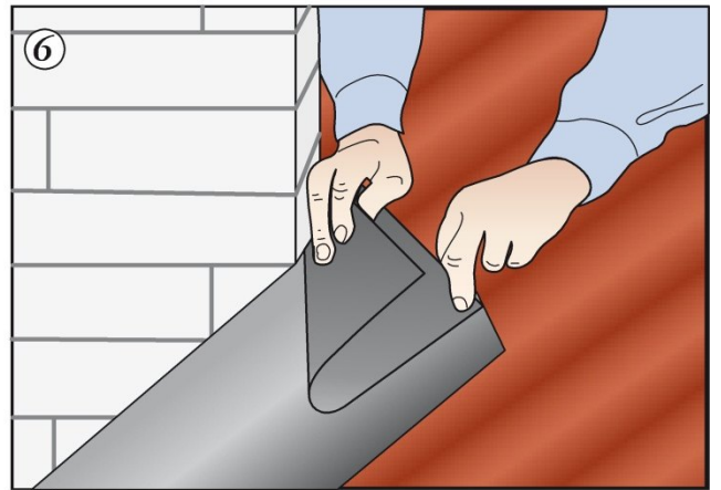
6 Дополнительно проклеить верхние углы обрезками ленты
