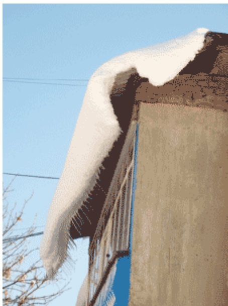
Рис. 4. Кровля этого дома была настелена летом 2008 года, фотография сделана весной 2009 г. Как и следовало ожидать, в марте 2011 года сползающий снег обломил свес крыши, переломив шифер выше середины листа. Фотографии разрушения нет (не было с собой фотоаппарата). Итог: кровля с величиной свободного свеса 20–25 см смогла «пережить» без потерь, всего две весны
