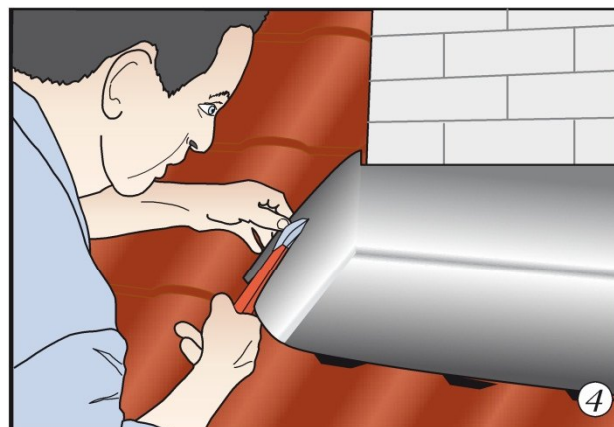
Ровно и по размеру подрезать края свинцовой полосы
