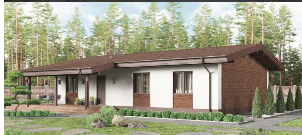
Отделка фасада: штукатурка и имитация бруса
