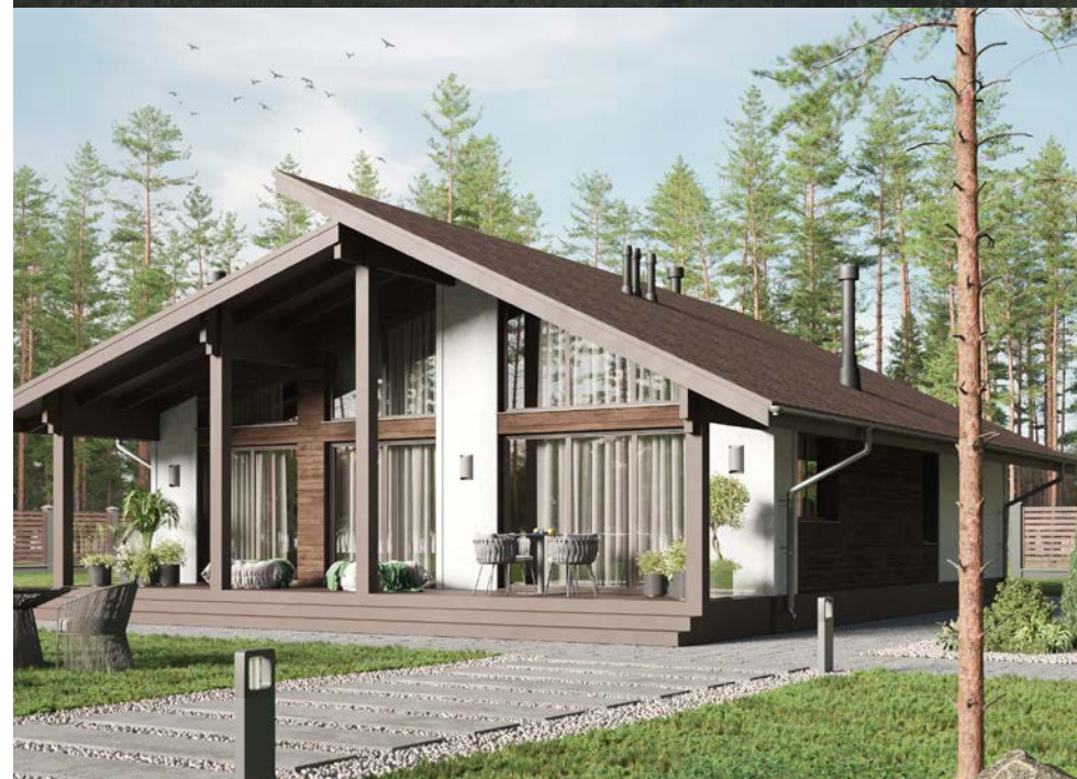
Отделка фасада: фасадные панели и имитация бруса
