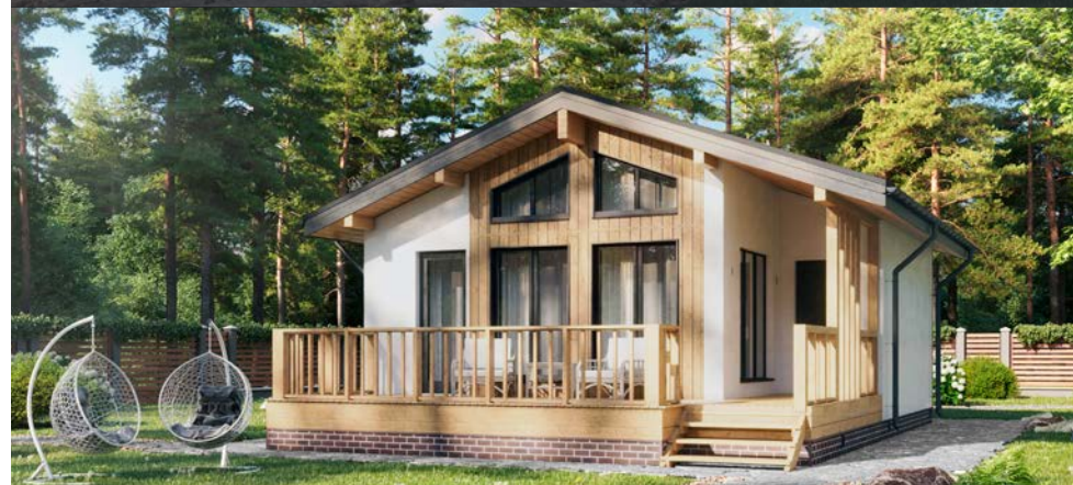
Отделка фасада: штукатурка и имитация бруса
