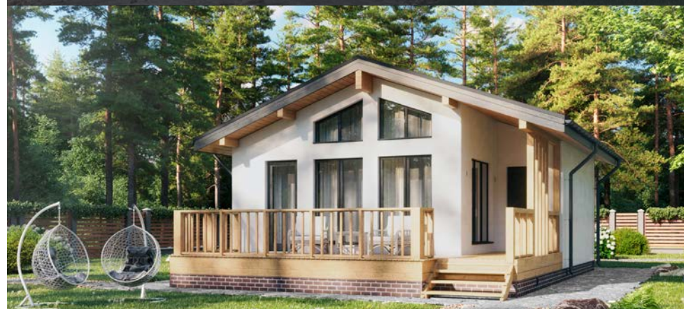
Отделка фасада: штукатурка
