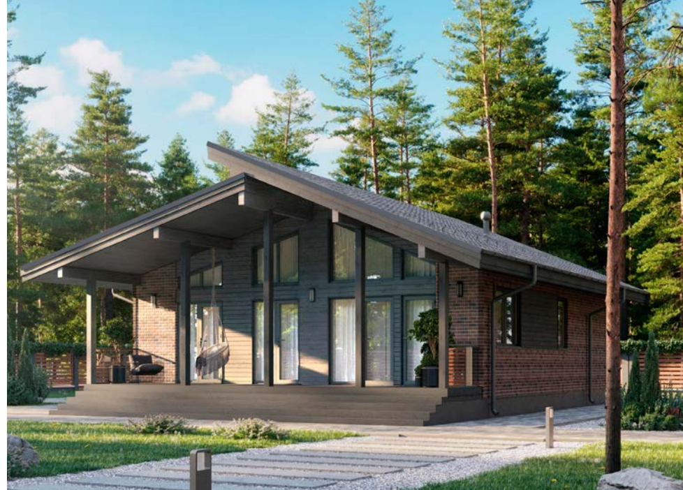
Отделка фасада: фасадные панели и имитация бруса
