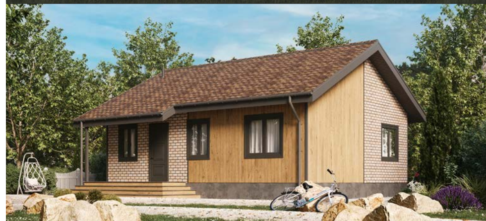
Отделка фасада: HAUBERK и планкен
