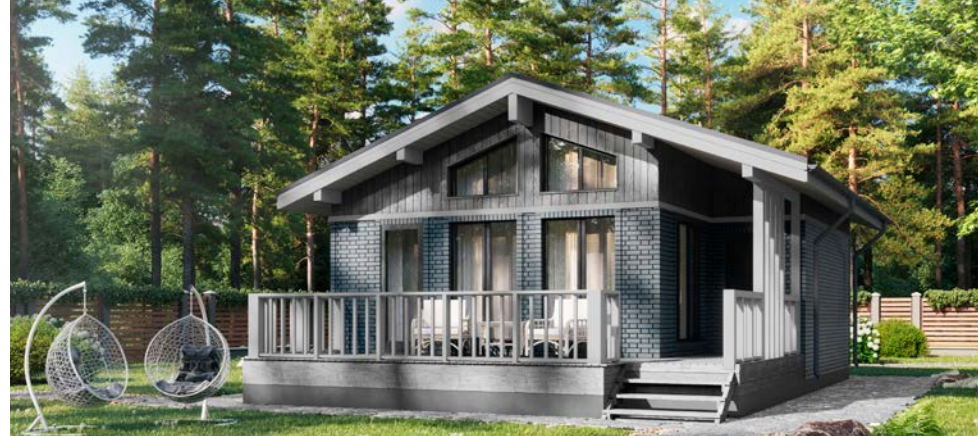
Отделка фасада: имитация бруса и фасадные панели
