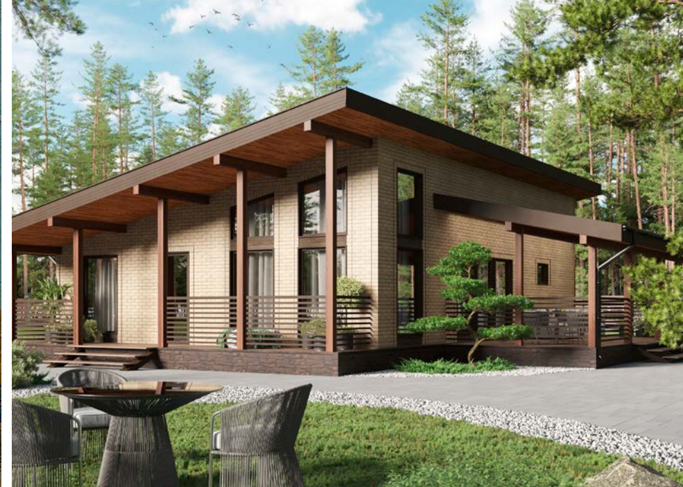
Отделка фасада: фасадные панели и имитация бруса
