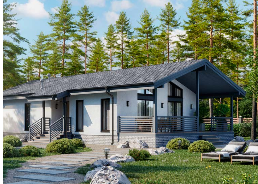
Отделка фасада: штукатурка и фасадные панели
