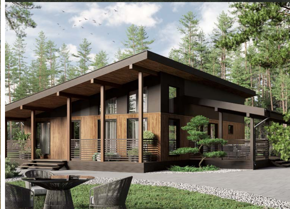
Отделка фасада: имитация бруса и штукатурка
