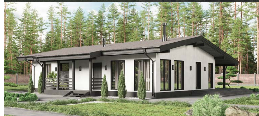
Отделка фасада: штукатурка и HAUBERK
